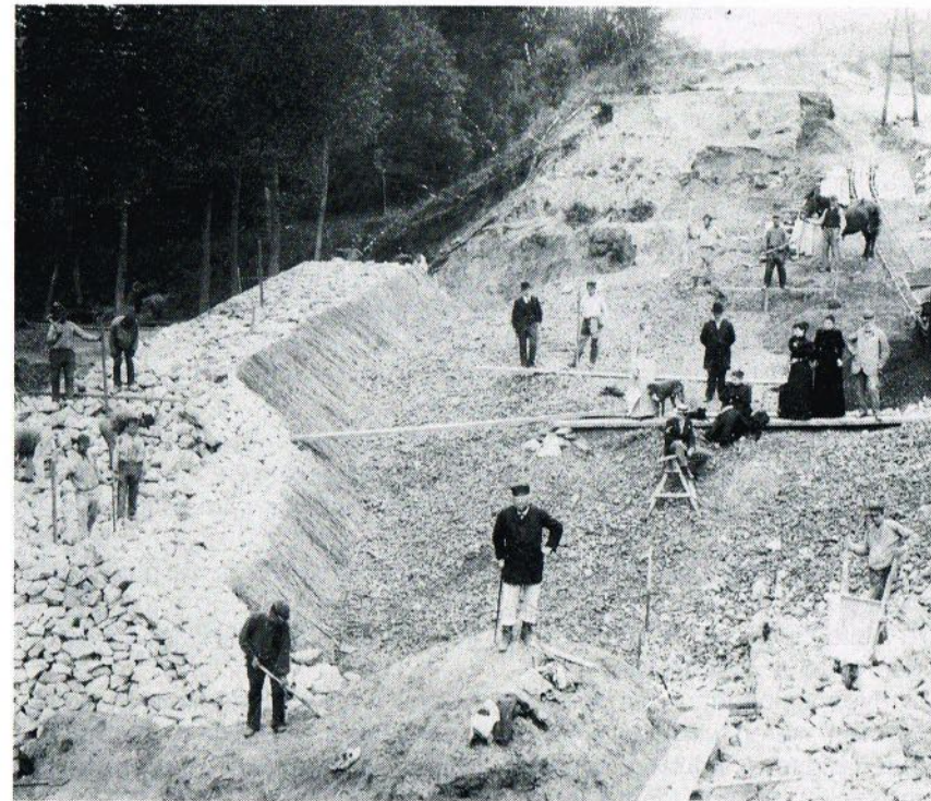
1893 - Een overzichtsfoto van de herstelwerkzaamheden. Links ziet men de aangevoerde basaltstenen. Moderne machines kende men niet en alles moest met de hand gebeuren. Men beschikte alleen over smalspoor met "kiepwagentjes". In het midden naast de dame in het zwart zien we burgemeester Vijgen en links van hem, in het wit gekleed, zijn dochter Aurelia. In het midden staat de uitvoerder van het werk.
