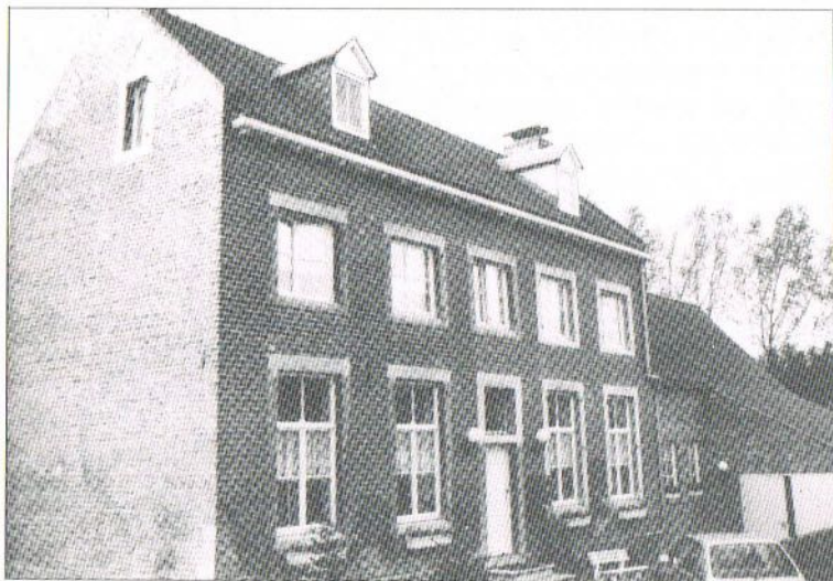
Urmonder Maasstraat 3 (foto: R. Zijlstra, H.V.M.)
