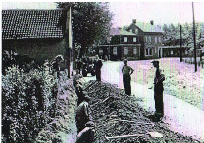
De aanleg van de waterleiding in de Nattenhover Koestraat (1955) Bron: documentatie HV. Maasstreek.
