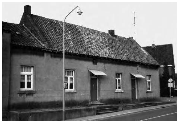
Oude situatie voor de bouw van het complex Paltshoek.
