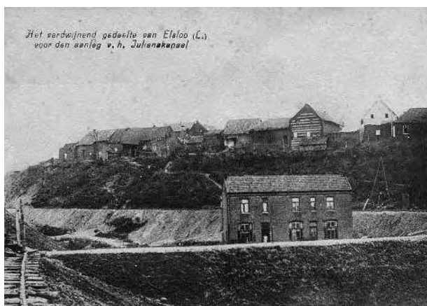
Elsloo tijdens kanaalaanleg.
