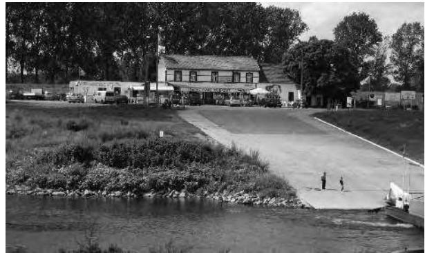
Het voormalige, afgebroken "Café Overzet", op de Belgische oever van de Maas bij Berg aan de Maas.
