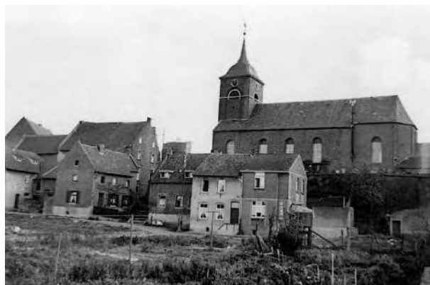
Zicht op Urmond vanaf de Bath, na afbraak van het lager gelegen gedeelte.
