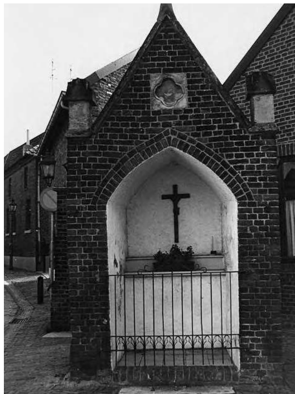
Kapel "Aan de Kaak" voor de restauratie.
