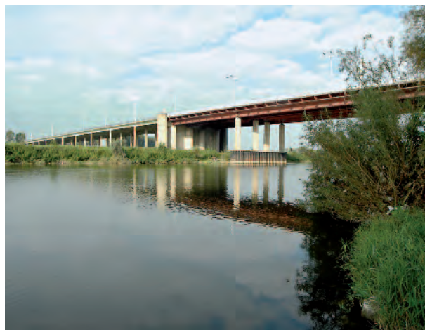
Brug over het Julianakanaal en de Maas naar België
