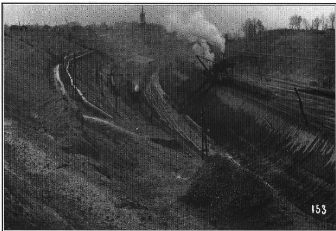
Overzicht van de werkzaamheden bij het afgraven van de laatste laag in de bocht van Elsloo.
