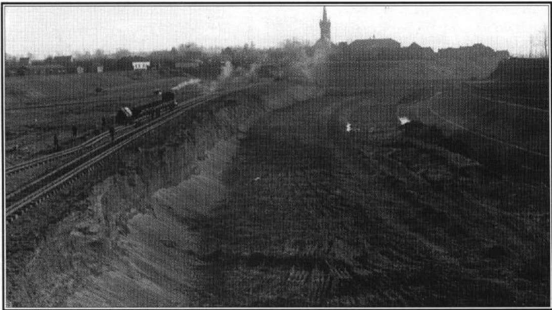
Het afgraven van de tweede laag. Het verschil tussen de grondlagen is duidelijk.
