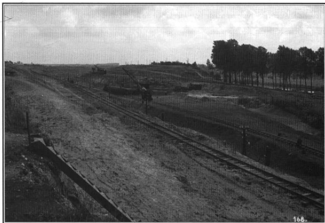
De doorgraving van de Scharberg, gezien vanaf de berg bij het Missiehuis te Stein.
