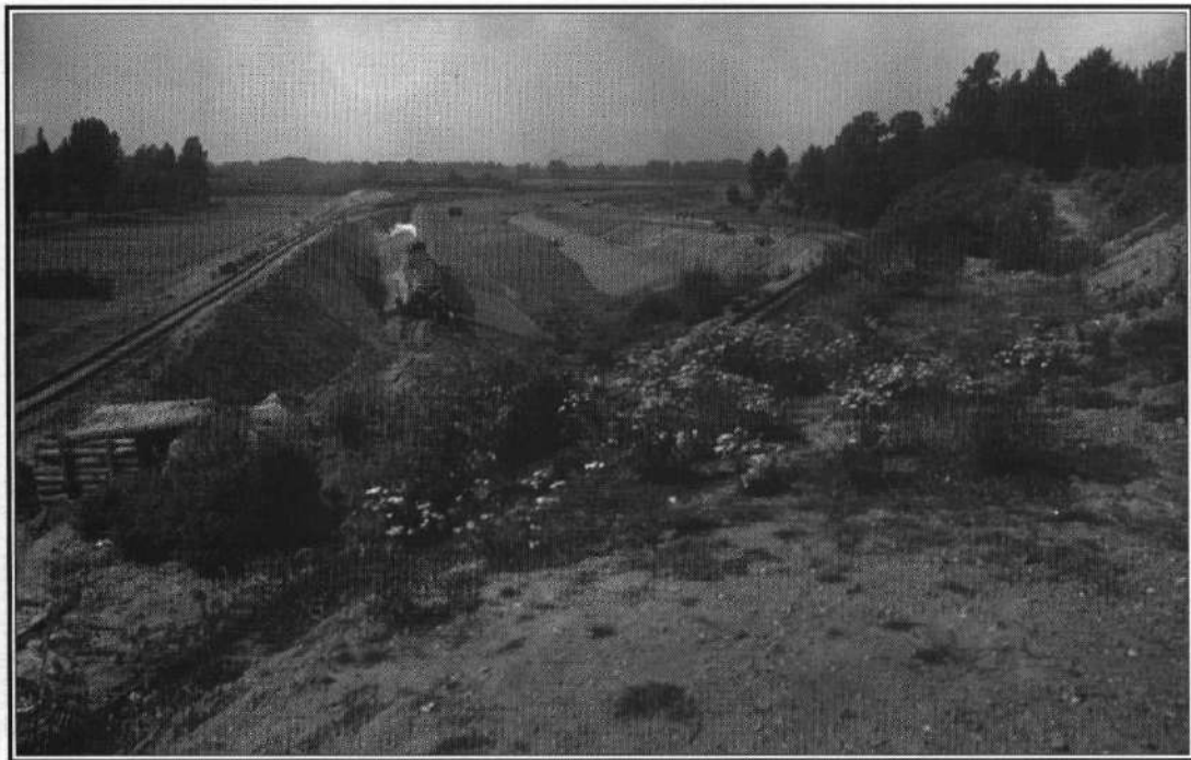
Aanleg van de dijken in Stein nabij het Missiehuis.
