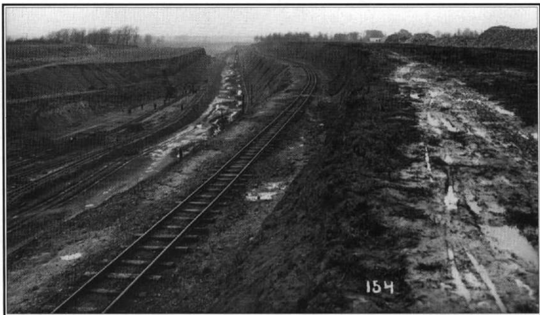
Dezelfde doorgang, nu gezien vanaf Elsloo. Ook is hier te zien, dat naarmate de uitgraving dieper werd, men meer last van het water had.
