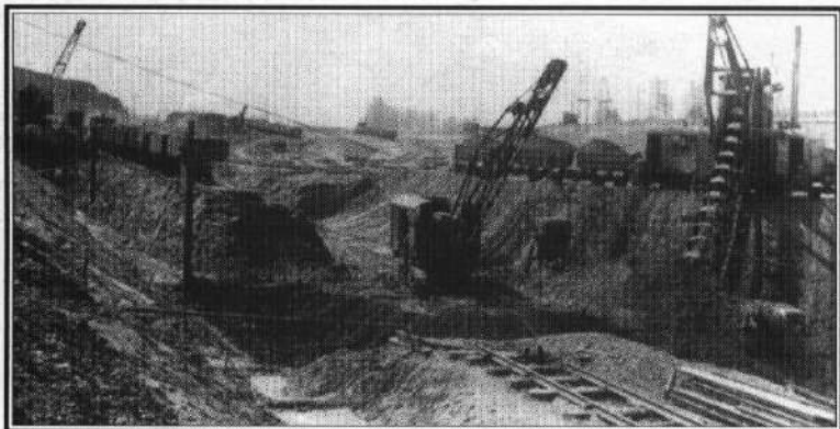
Drie draglines en de baggermolen in Stein aan de arbeid.
