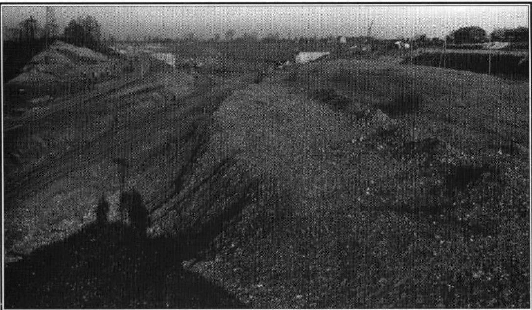
De brugpijlers van Elsloo ontkist en de weg naar de Maas in aanleg.
