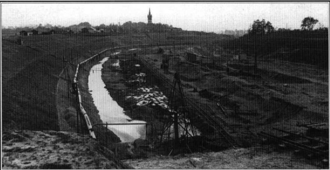
De pijpleiding langs het talud diende voor de afvoer van het grondwater uit de pompen naar de beek in Elsloo. Anderzijds werden met dit water nieuwe putten gespoeld. De boortoren op de voorgrond, waarmee via waterdruk een pompbuis werd aangebracht.
