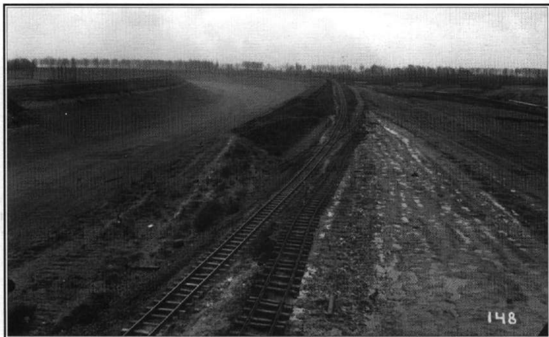
Overzicht van de werkzaamheden nabij de brug in Stein, gezien in zuidelijke richting.
