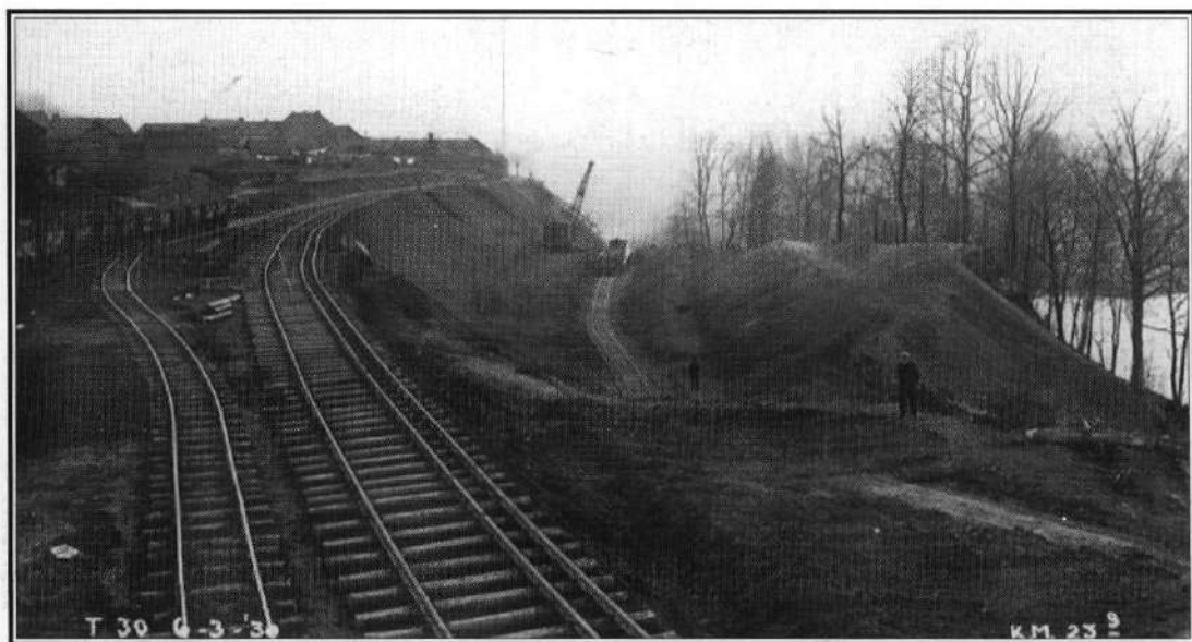
De brede spoorlijn in het midden werd door de baggermolen gebruikt. Door een extra rail aan te brengen kon de lijn ook gebruikt worden door treinen.
