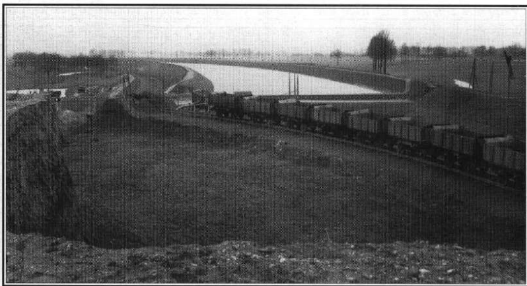
De klei uit de kleiput in Geulle voor de bekleding van de dijk bij Stein en Urmond werd vervoerd via een spoor dat vanaf Elsloo aan de voet van de dijk naar Geulle liep. Het grind voor het vullen van de kleiput in Geulle ging ook via dit spoor.
