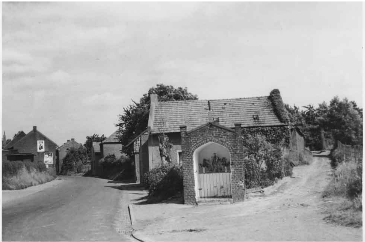
Elsloo, kruising Stationsstraat met Heirstraat
