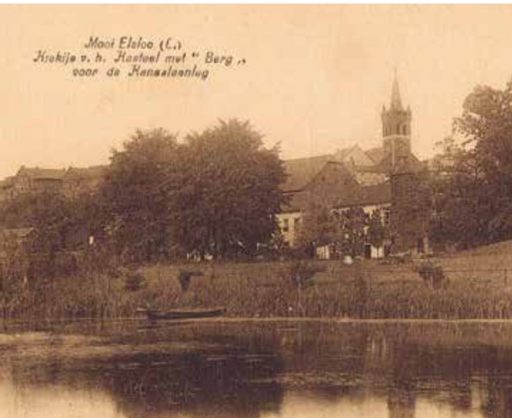
Het kasteel voor de aanleg van het Julianakanaal rond 1920. Links naast de bomen "de Auwe Berg".
