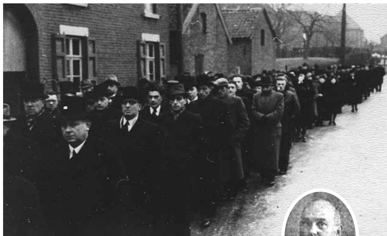
De begrafenisstoet bij de uitvaart van burgemeester Eussen, ter hoogte van Raadhuisstraat 30. Naast de nog bestaande boerderij "de Bourgondische hoeve" lag toen nog een huis. Daarnaast lag het lijkenhuisje. Hier werden overledenen opgebaard die aan een besmettelijk ziekte waren gestorven of die om andere redenen niet thuis opgebaard konden worden.
