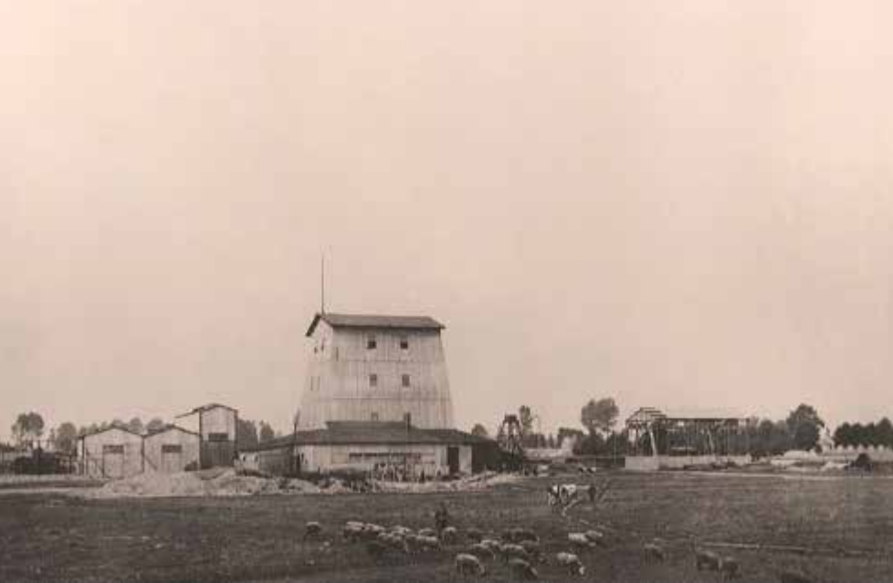
Links • De boortoren in aanleg voor de schacht van de Staatsmijn Maurits, gelegen "op de hei" bij Lutterade in Geleen.
