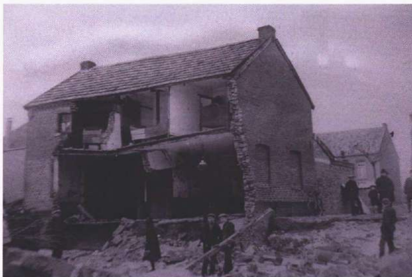
De ingestorte achtergevel van het huis van Pierre Westhovens, Kerkstraat 1.
