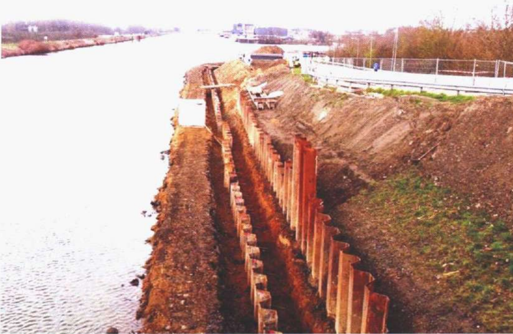
Damwerkzaamheden tussen de haven en de brug van Stein.
