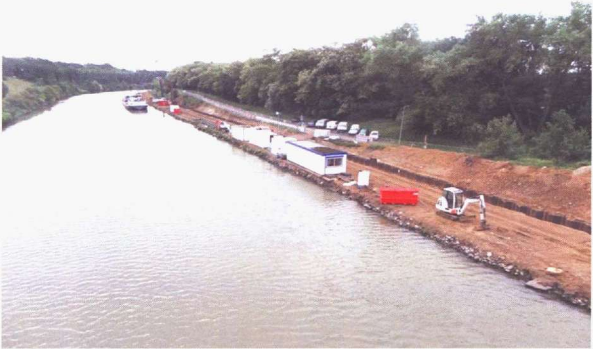
Verbreding van het Julianakanaal door damwand plaatsing ter hoogte van de Scharberg.
