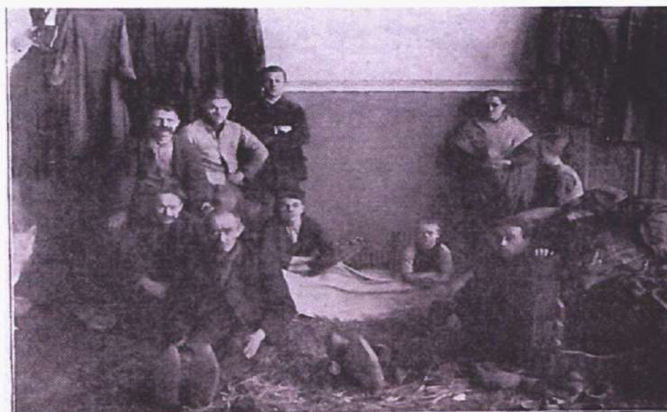
In een klaslokaal op de eerste verdieping van de school hebben de mensen van de ingestorte huizen onderdak gevonden.
