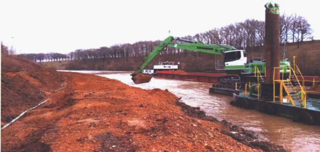
Damwerkzaamheden aan de scharberg voor de brug van Elsloo.
