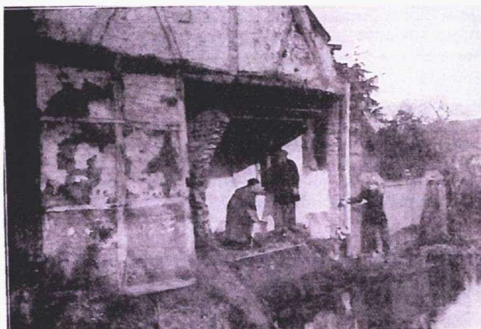
Een vakwerkhuis waar een gedeelte van de voor- of achtergevel is weggespoeld.
