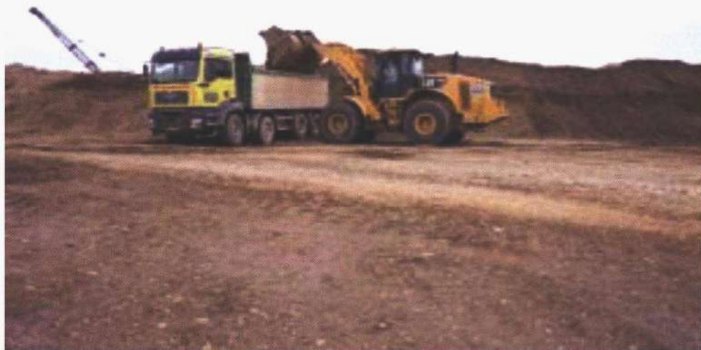
Het gewonnen zand en grind verladen in vrachtwagens en vervoeren naar de was- en breekinstallatie aan de Veldschuurdijk in Meers.
