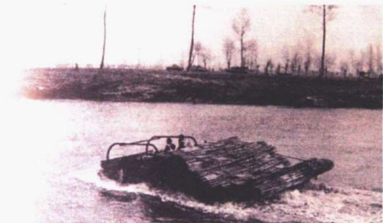
Nieuwe technieken werden ontworpen om aan land te kunnen komen met de steile oevers. Buffaloe met "carpet", aan elkaar gebonden stokken.
