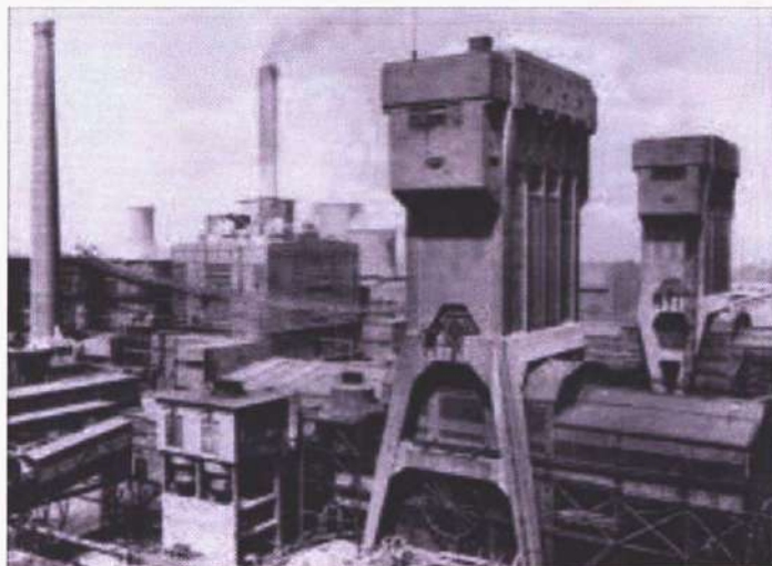
Met de aanleg van de "Staatsmijn Maurits" werd in 1915 begonnen, een jaar later startte men met de bouw van de eerste twee schachten.
