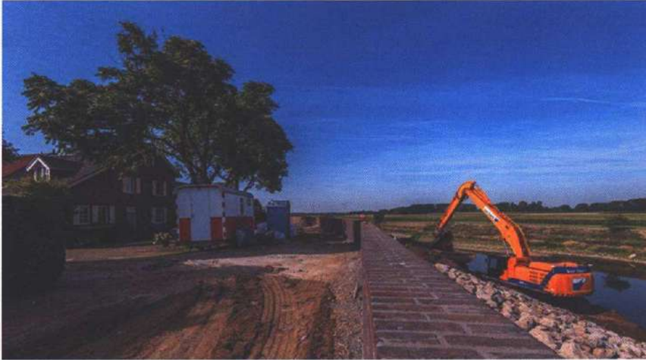
Eind 2017 was de verhoging van de dijk in Maasband klaar.
