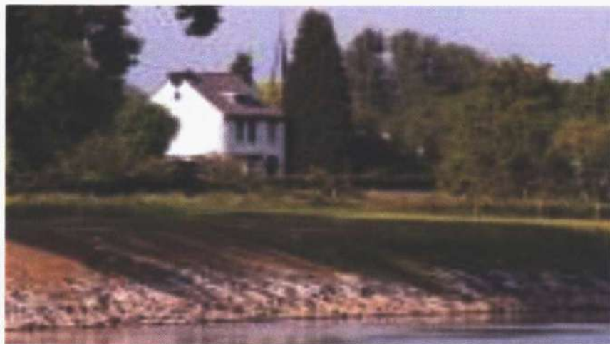
2010 De verstevigde dijk. Deze is nu bestand tegen de sterke stroom in de buitenbocht tijdens hoge waterstanden.
