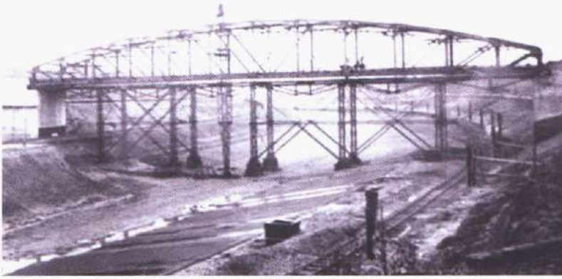
Het betonnen van de bodem van het kanaal. De afvoerpijp die het grondwater vervoert naar het kasteel in Stein.
