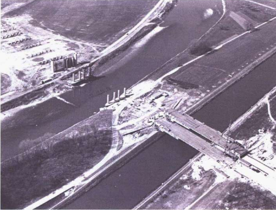
Circa 1970. De aanleg van de autoweg over het Julianakanaal en de Maas naar Antwerpen.
