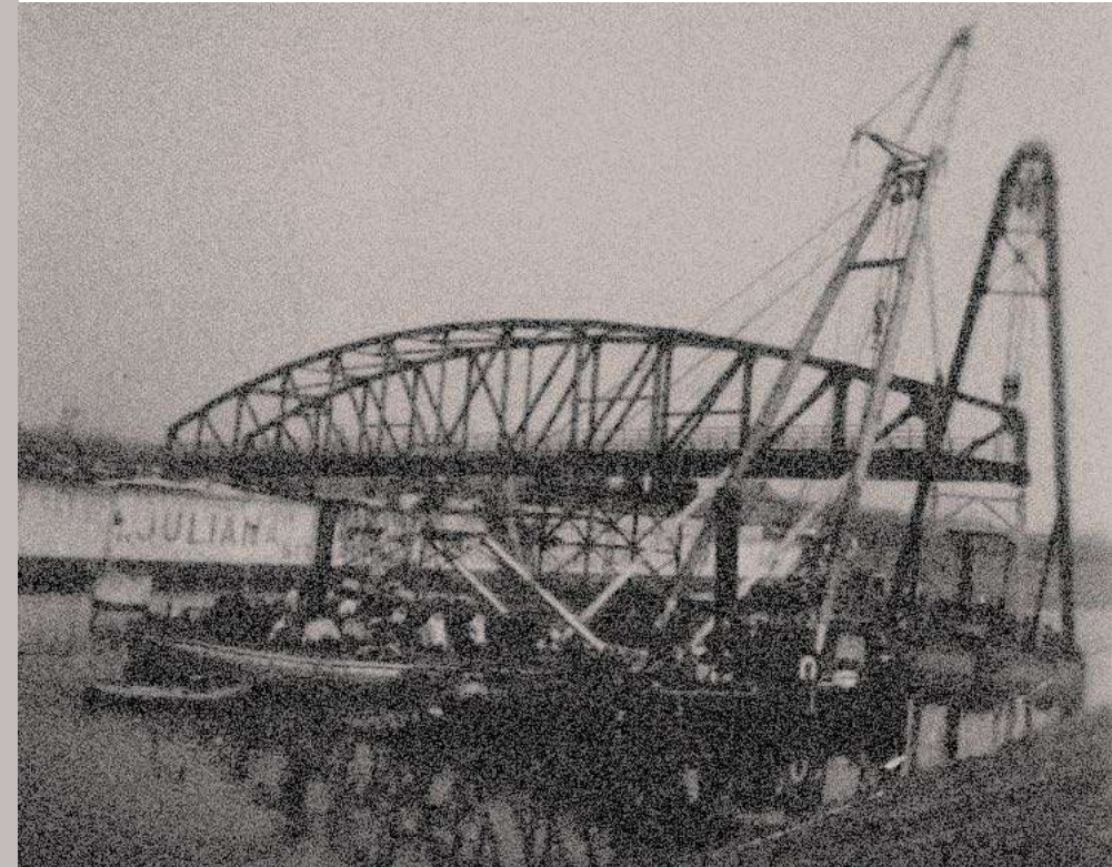
De brug wordt op de pontons gelegd
