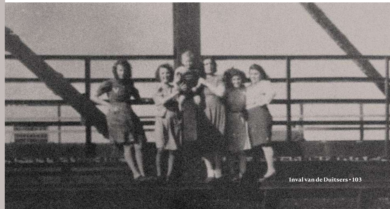
Poseren op de brug in de reparatieperiode
