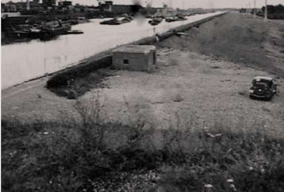
Kazemat bij de Kattekop te Urmond
