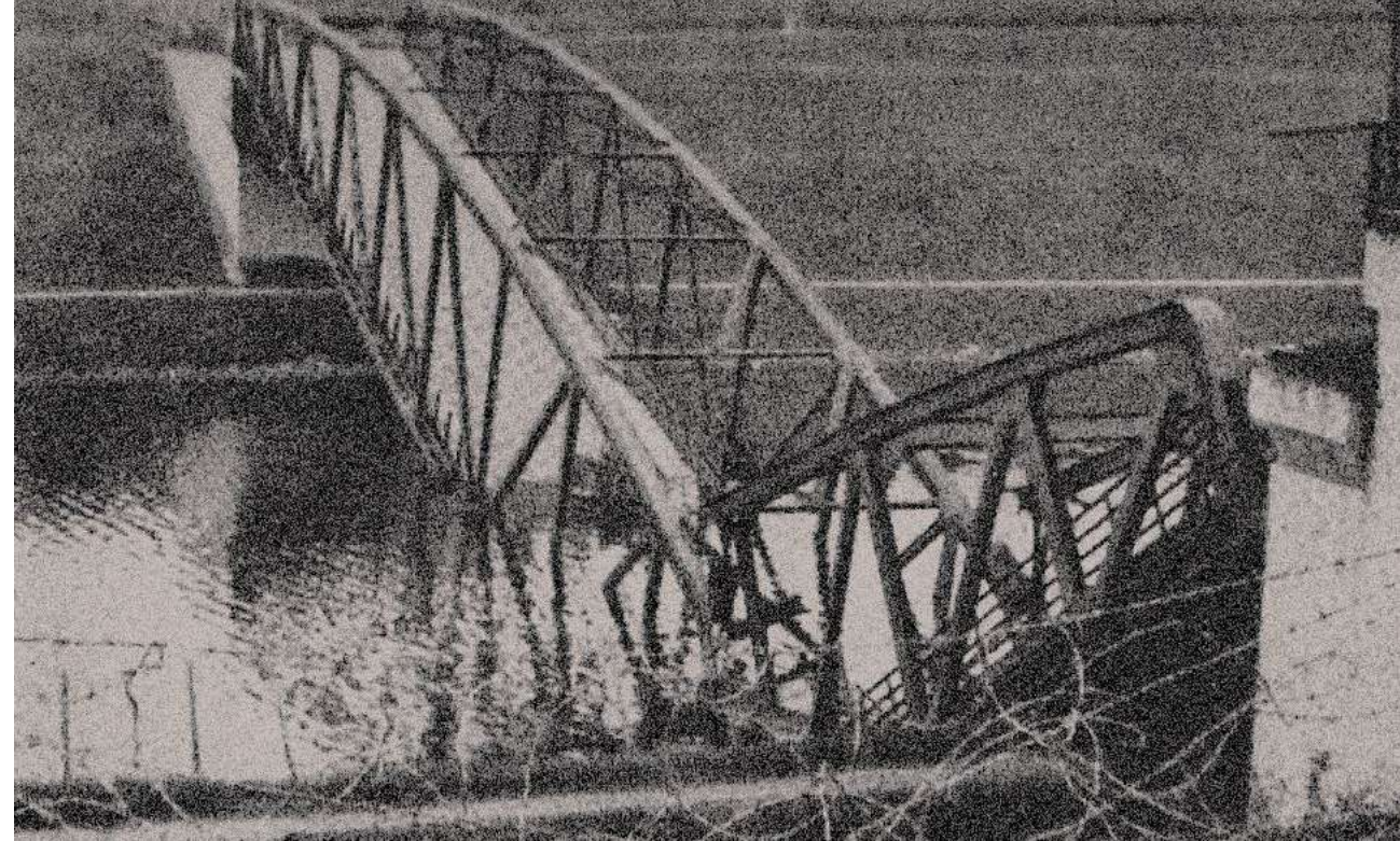
Opgeblazen brug van Elsloo
