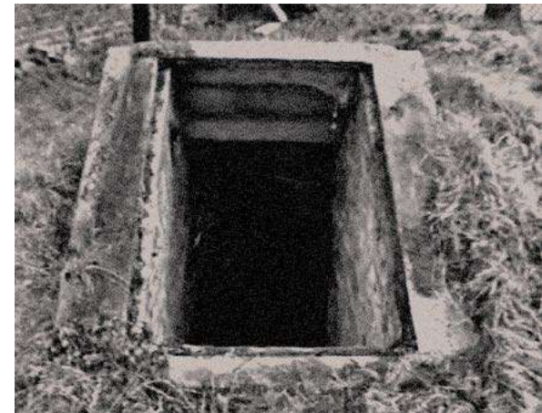
Ingang van de schuilkelder
