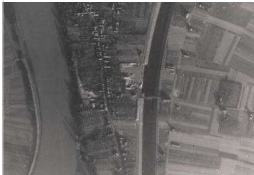
Luchtopname Baileybrug over Julianakanaal bij "Juliana" in Bergaan de Maas
