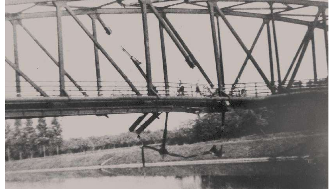
Zwaar beschadigde brug van Urmond nog in gebruik bij evacuatie van Meers en Maasband
