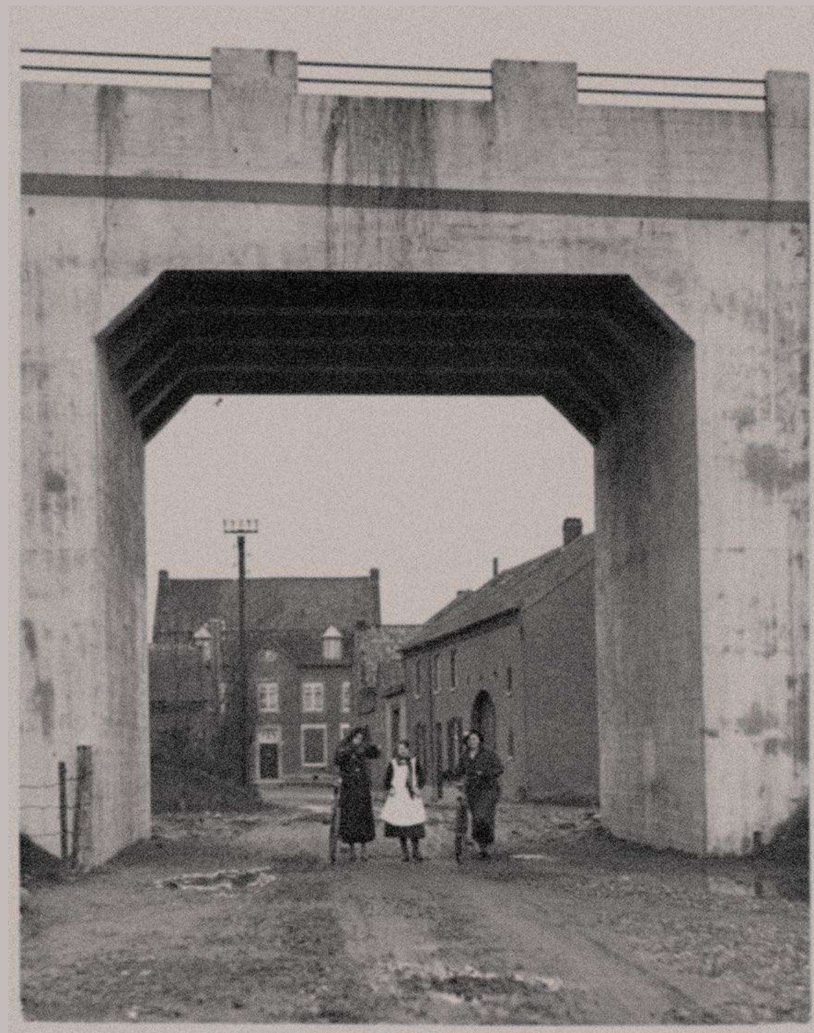
Viaduct over de Brugstraat in Stein.
